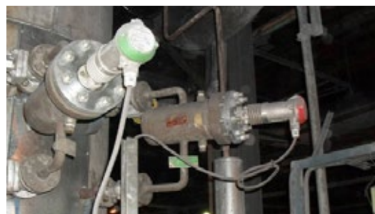
Trimod Besta フロートチャンバー : I021-1C0RC1 タイプ
