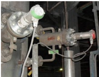
液位开关型号：HAA 22C01 041 浮子室型号：I021-1C0RC1
