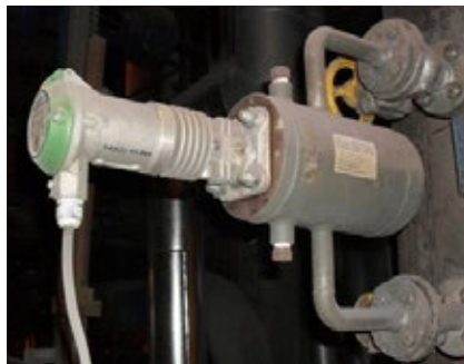
液位开关型号：HAA 01 041 浮子室型号：S021-0RC1
