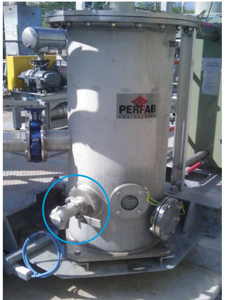
Trimod'Besta Füllstandschalter als Tiefalarm
