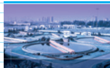
Trattamento delle acque
