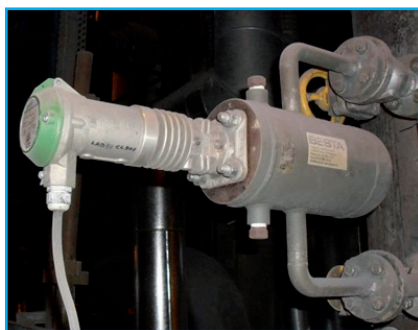
Переключатель уровня Trimod Besta тип HAA 01 041 Поплавковая камера Besta тип S021-0RC1
