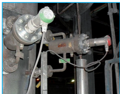
Переключатель уровня тип HAA 22C01 041 Поплавковая камера Besta тип I021-1C0RC1
