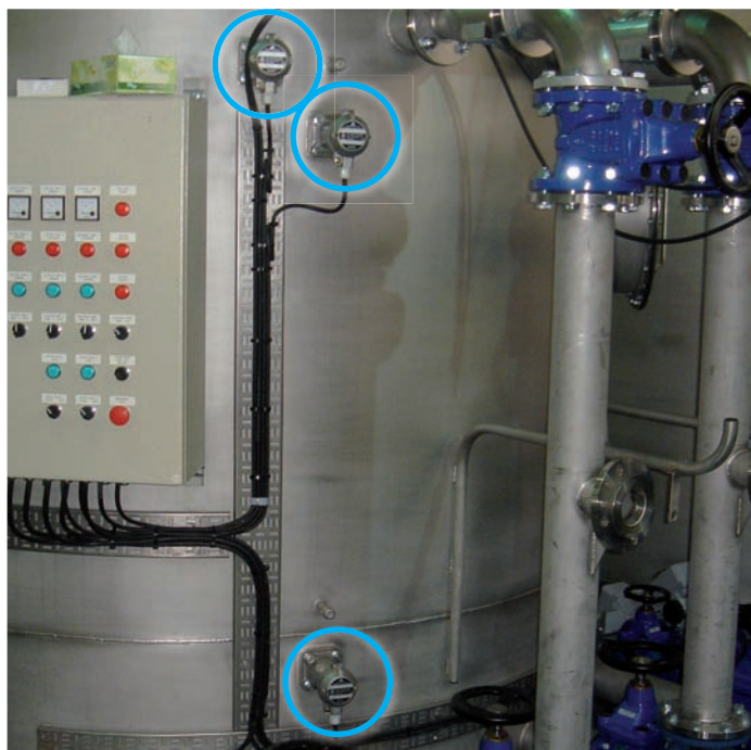
Contacteurs de niveau type: A 01 051E15
