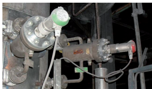
Trimod Besta レベルスイッチ: HAA 22C01 041 タイプ Trimod Besta フロートチャンバー: I021-1C0RC1 タイプ
