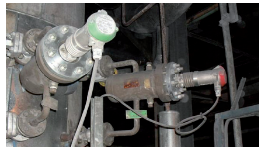
Trimod Besta Füllstandscharter Typ: HAA 22C01 041 Trimod Besta Schwimmerkammer Typ: I021-1C0RC1
