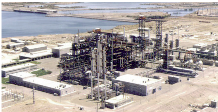
Planta de producción de agua pesada Arroyito, Argentina
